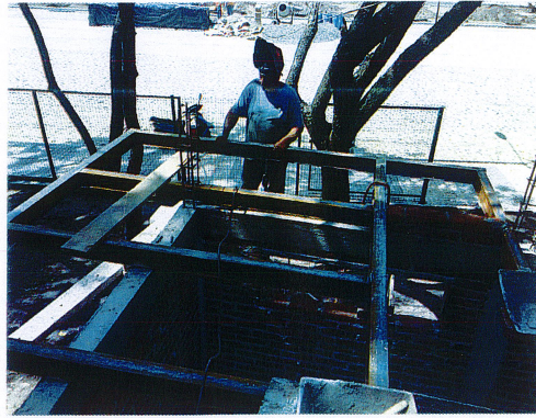
SOLDAR VIGAS EN BAÑOS DE LA OBRA DE PASEO COMERCIAL DEL PROGRAMA FOCOCI 2022.
