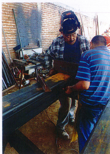
HABILITAR Y SOLDAR COLUMNAS METALICAS PARA AREA DE PERGOLAS
