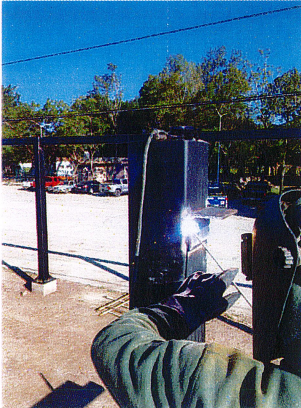
TRABAJOS DE SOLDADURA EN AREA DE PERGOLAS DEL PROGRAMA DE FOCOCI 2022.
