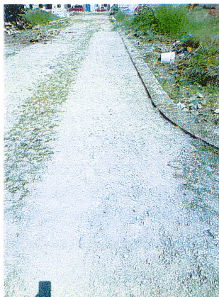
REEMPEDRADO EN LA CALLE MARCELINO HERNANDEZ ENTRE LAS CALLES UXMAL Y CALLE GENERAL PORFIRIO DIAZ
