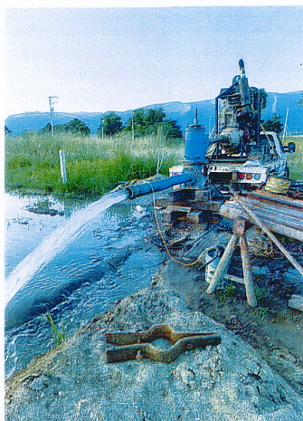
ADEME Y AFORO DE NUEVO POZO PROFUNDO EN LA COLONIA VALLE DE EL GRULLO
