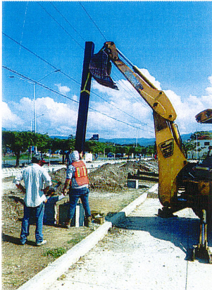
COLOCACION DE COLUMNAS METALICAS EN AREA DE COMERCIAL Y PERGOLAS DE LA OBRA DE PASEO COMERCIAL, CULTURAL Y DEPORTIVO DEL PROGRAMA DE FOCOCI 2022.
