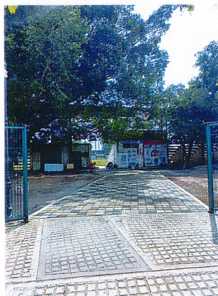
INSTALACION DE ADOQUIN EN ANDADOR DE LA UNIDAD DEPORTIVA MUNICIPAL
