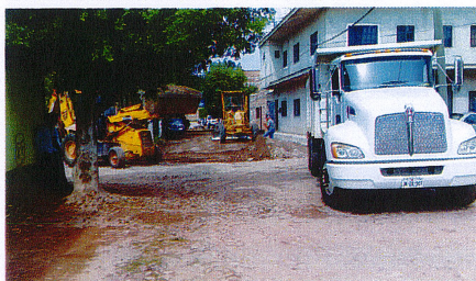
TRABAJOS CON LA MAQUINARIA DE SADER Y DEL MUNICIPIO
